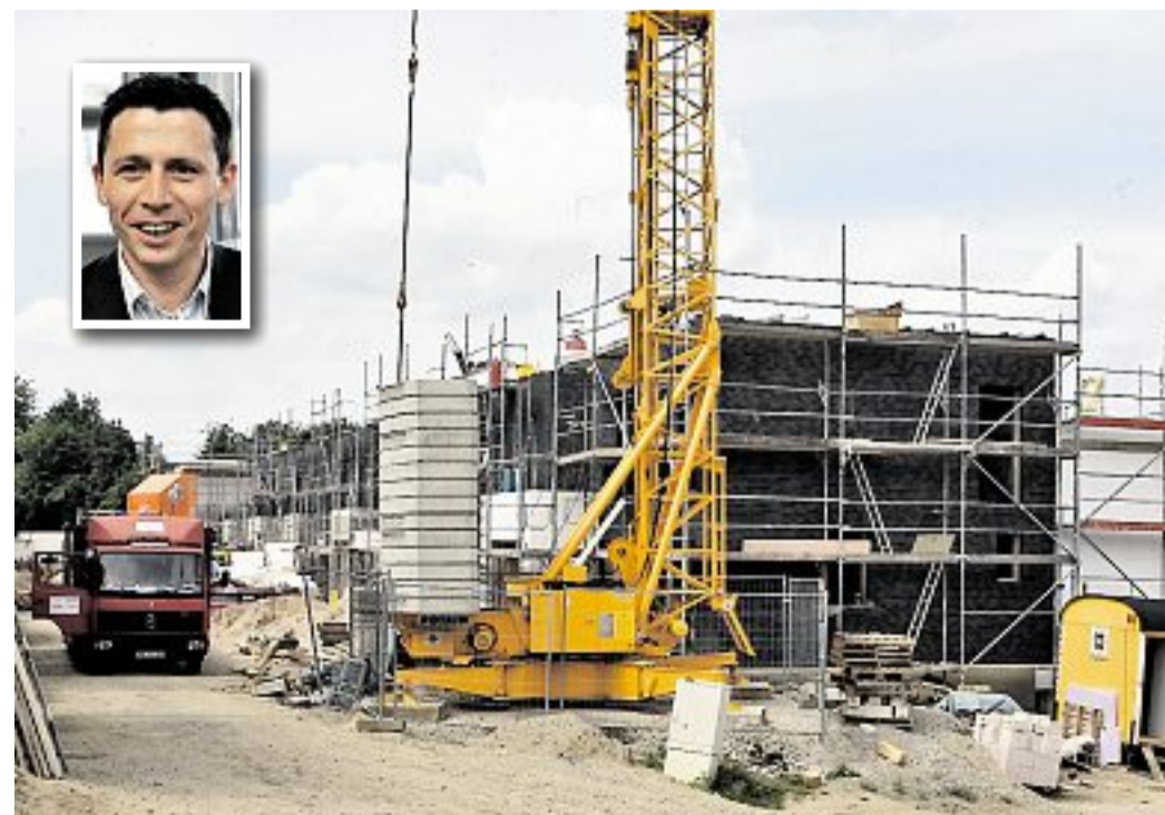
Tatort Klieversberg: Die Baustelle an der Martin-Luther-Straße wurde zum Ziel von Dieben. Investor Marco Moretti (kleines Bild) rechnet nicht mit Bauverzögerungen. Photowerk (bb)
